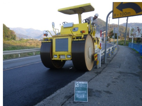
舗装修繕状況
