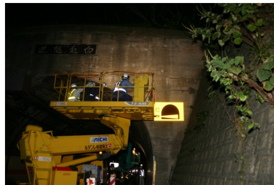
トンネル点検状況
