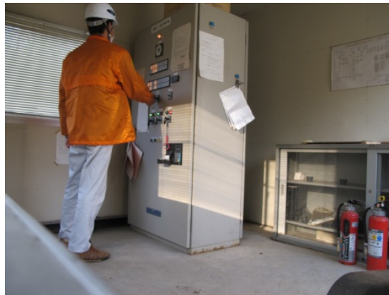
機械設備点検状況（ポンプ装置）
