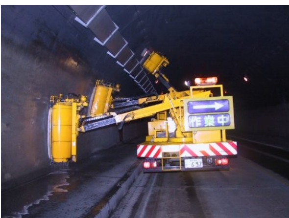
トンネル清掃状況
