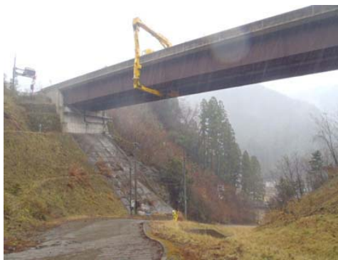
橋梁点検状況
