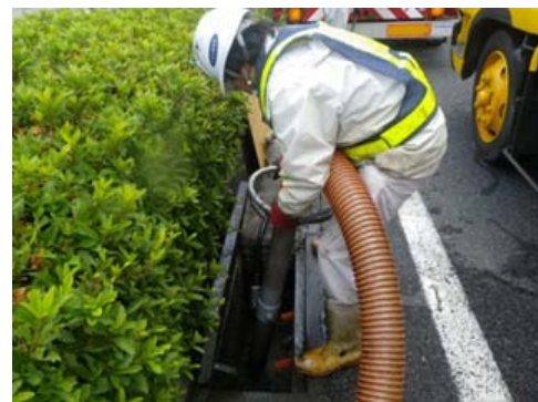
排水施設清掃状況
