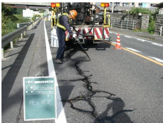
シール材注入状況
