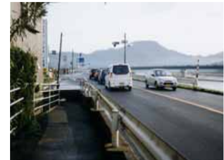
供用後の状況（袋河原交差点）
