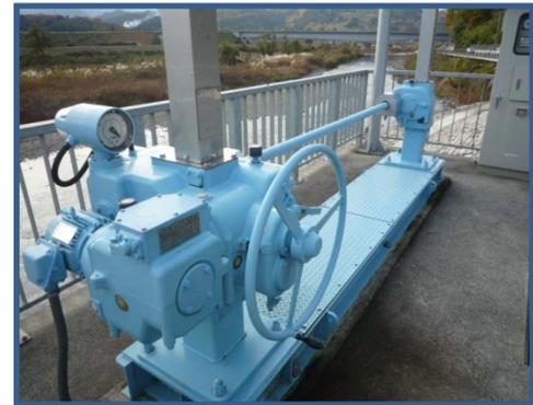
電動式の開閉装置
