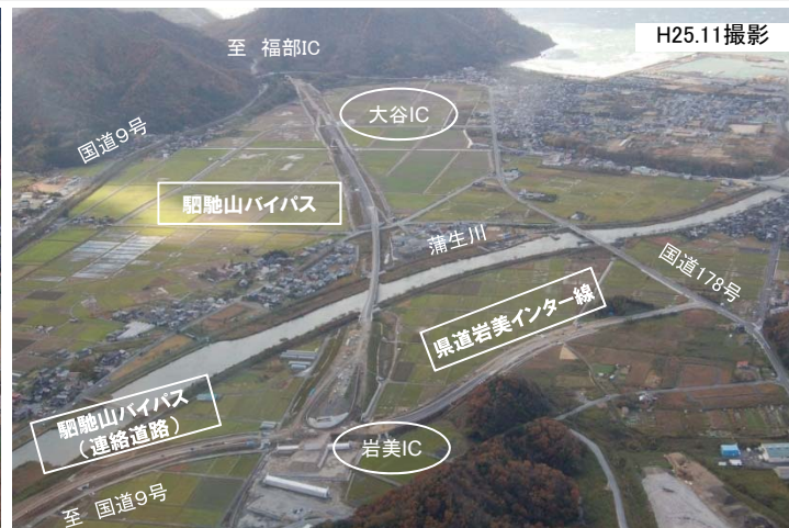
【写真②】岩美町本庄地区(岩美IC付近)
