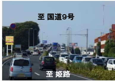
▲写真：国道29号の渋滞状況（JR山陰本線跨線部）
