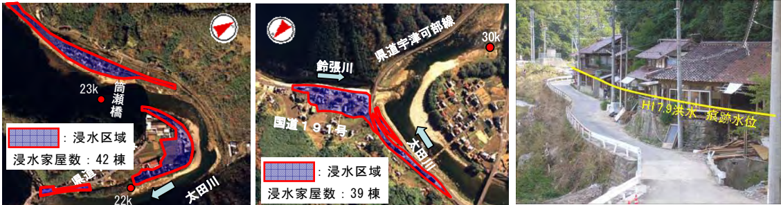
22. 0k～23. 3k 筒瀬川合流点上流付近（広島市安佐北区安佐町大字筒瀬地先） 22. 0k～23. 3k 筒瀬川合流点上流付近（広島市安佐北区今井町大字今井田地先） 30. 4k～30. 8k 鈴張川合流点付近（広島市安佐北区安佐町大字飯室地先） 被災痕跡水位（広島市安佐北区安佐町大字久地地先）
