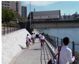
北大橋左岸のアンダーパス
