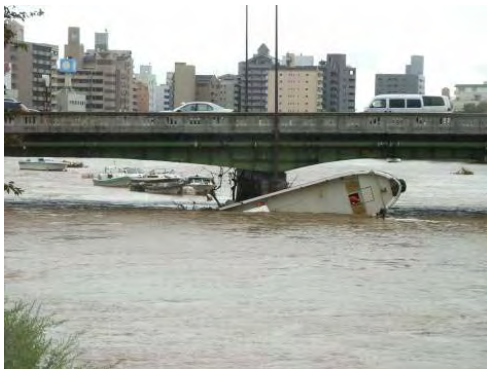
橋脚に引っ掛かったプレジャーボート
