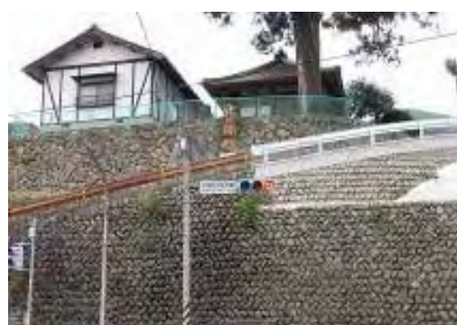
太田川中上流部で見られる玉石を用いた石垣
