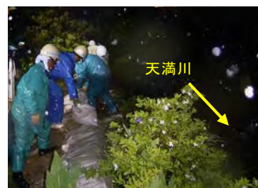
観音地区の土のう積み状況
