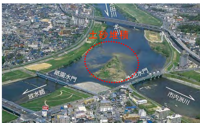
分派地点の土砂堆積状況
