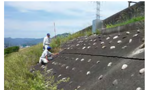
堤防点検の状況
