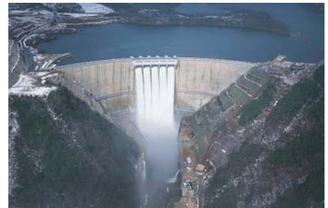
太田川上流部（滝山川）の温井ダム
