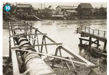
昭和3年6月洪水 栄橋及び水道管流失状況
