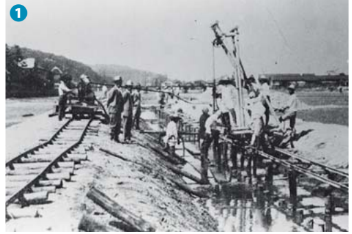
己斐護岸基礎工事（昭和10年）
