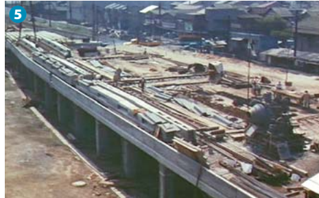
横川駅付近の山陽本線高架化工事の状況(昭和38年)
