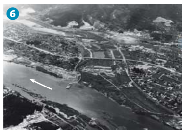
大芝・祇園水門着工当時(昭和37年)
