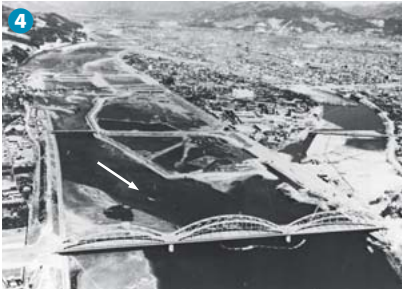
旭橋上流の掘削と福島川埋立状況(昭和35年)
