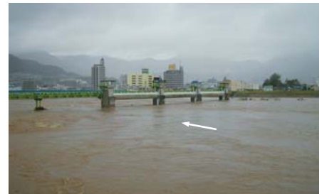
平成17年9月洪水時の祇園水門 平常時は少ししか開いていない水門を全開にして放水路に多量の水を流し、市内派川の洪水氾濫を防いでいる。
