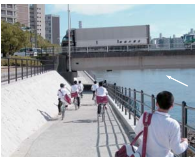
北大橋アンダーパス
