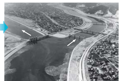
通水後の放水路(昭和40年)
