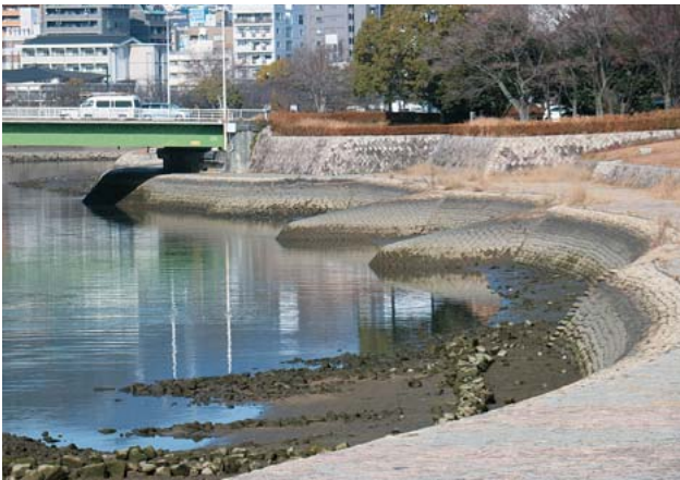
基町環境護岸に復元された水制
