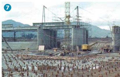
大芝水門の松杭基礎
