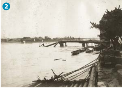
大正8年7月洪水 相生橋流失状況
