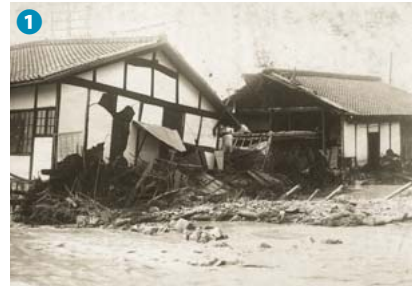
大正8年7月洪水 三篠町打越家屋被害状況
