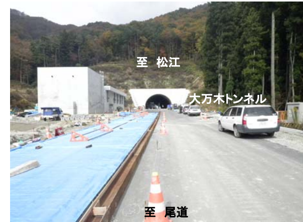
【写真④】 おおよろぎ 大万木トンネル付近
