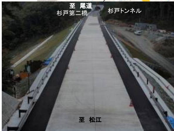
すぎど 【写真①】 杉戸地区 杉戸トンネル付近
