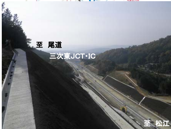
【写真①】三次東JCT・IC付近
