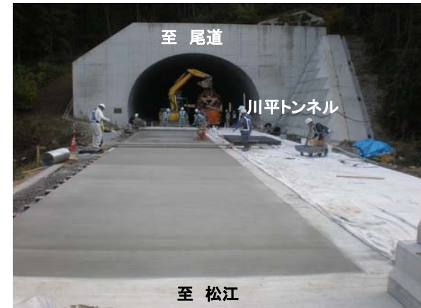
【写真③】川平トンネル付近
