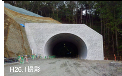
写真③ トンネル施工状況(新湯里トンネル)
