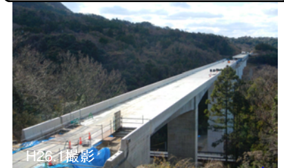
写真② 上部工施工状況(馬路第1高架橋)
