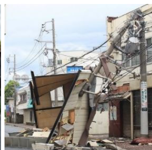
<飛来物による電柱倒壊の事例>
