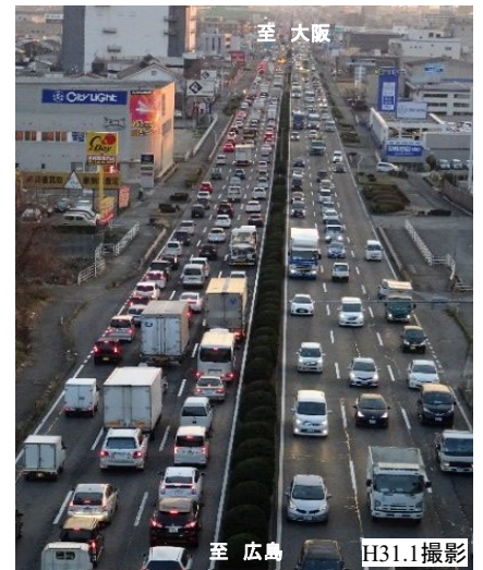
【写真①】国道2号の渋滞状況
