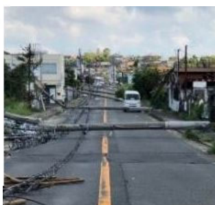
<電柱の倒壊による道路閉塞の事例>
