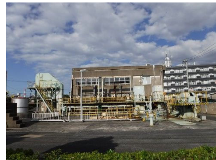
《写真② 鶉の島ポンプ場》
