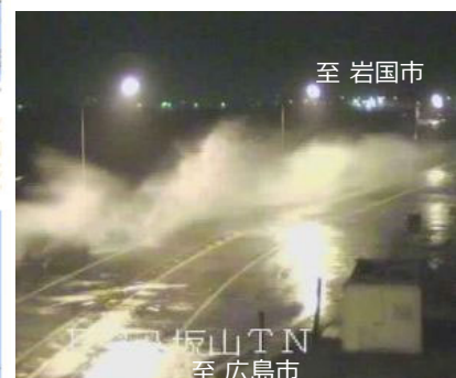
【写真③】越波の状況(H17.9)
