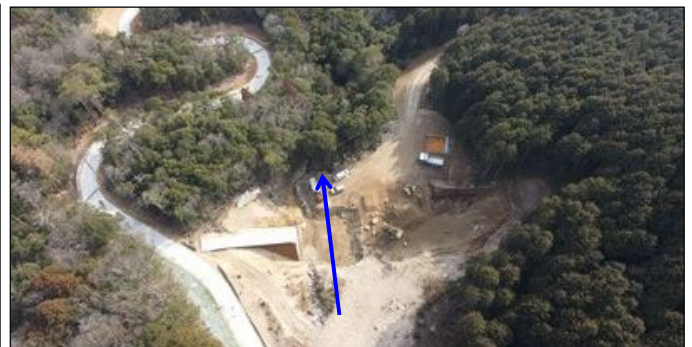
現況空撮写真
