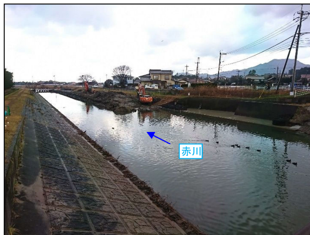
【参考(他事業)】 河道掘削状況
