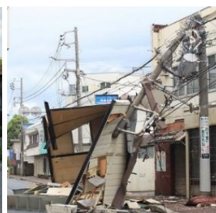
<飛来物による電柱倒壊の事例>
