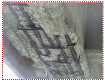
② 損傷状況 (主桁の劣化・鉄筋露出)
