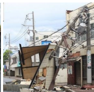
<飛来物による電柱倒壊の事例>
