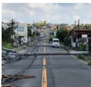
<電柱の倒壊による道路閉塞の事例>
