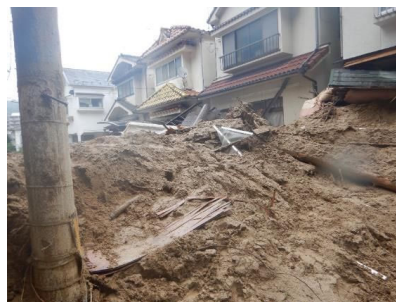
土石流による被災状況 (令和3年8月 西区田方)
