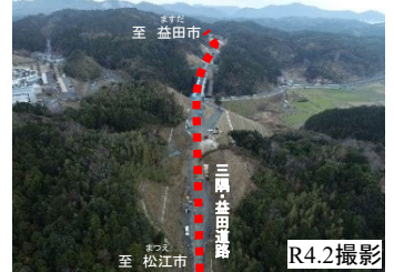
【写真①】古市場地区の施工状況
