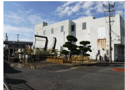
《写真① 栄川ポンプ場》
