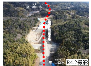
【写真②】土地区の施工状況
