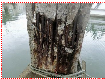
① 損傷状況 (橋脚部の鉄筋露出)
