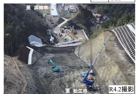
【写真①】出雲・湖陵道路 東神西地区の施工状況
