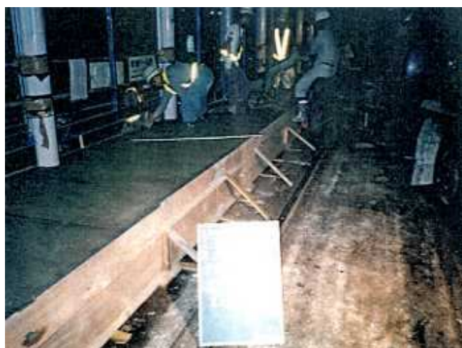
古い電停を取り込んだ形で、新しい電停のコンクリートを打設
