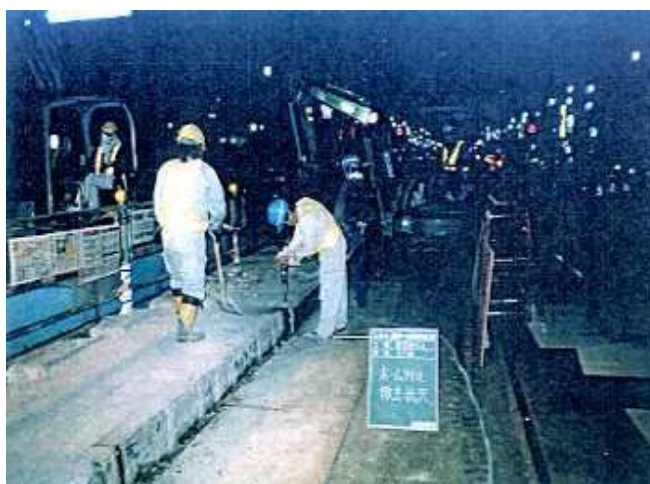
古い電停のタイルを撤去
