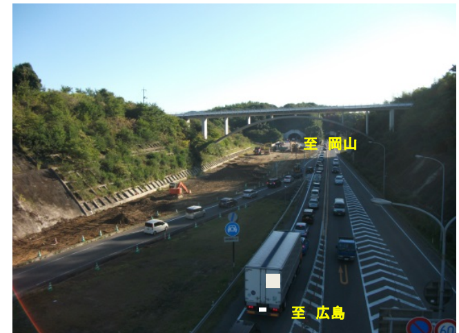
【写真】2車線区間の渋滞状況
