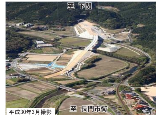
長門IC(仮称)付近の状況 (写真③)
