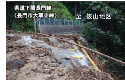
H27年8月25日の被災状況（写真）
