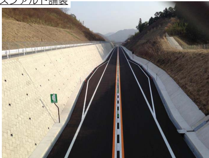
アスファルト舗装
