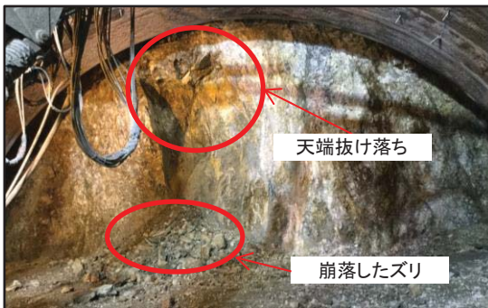
切羽状況 (崩落状況)
