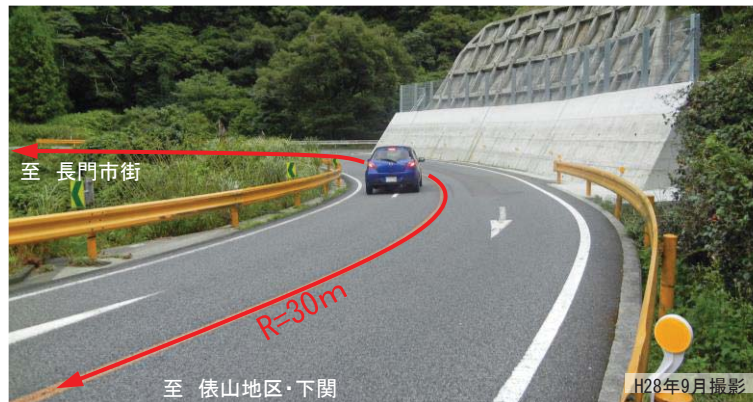
下関長門線のカーブ区間の状況（写真②）
