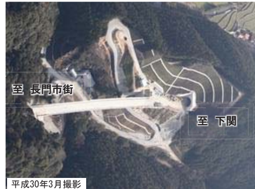
赤ノ谷橋の状況 (写真②)
