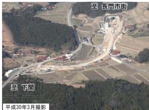
俵山IC(仮称)付近の状況 (写真①)
