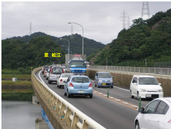
写真①: 米子大橋において松江方面を望む
