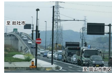
写真① 野殿西町交差点付近
