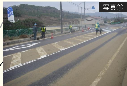
冬期の飛砂及び堆砂 持石海岸並行区間において、冬期に発生
