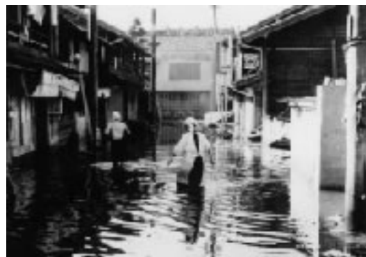
昭和34年9月洪水(伊勢湾台風) (岐阜市芥見付近の浸水状況)
