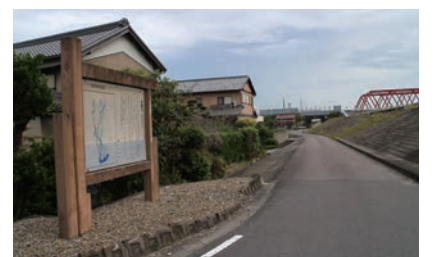
木曾川大橋左岸側の白鷺川締切り地点（木曾岬町白鷺西白鷺川）
