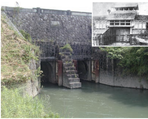
人造石（三和土）工法による現五六閘門 右上：明治21年改築当時の牛牧輪中間門樋 〈出典：穂積町史 史料編第2巻〉
