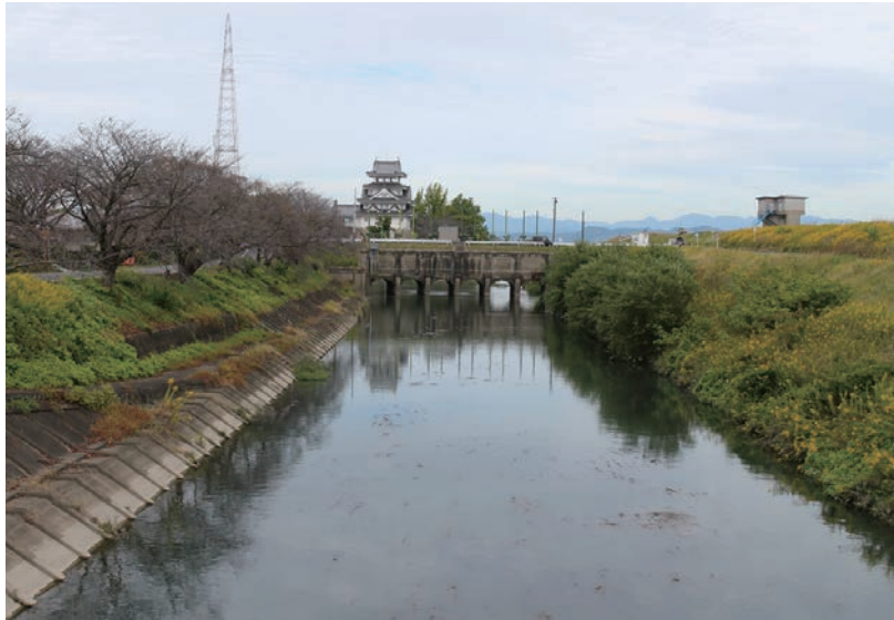
長良川右岸堤（右側）に隣接した新犀川排水路から犀川制水樋門後方の墨俣城を望む
