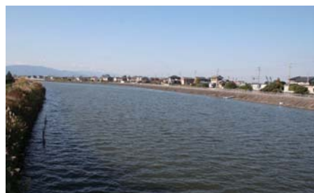
筏川の現況(新筏川橋より下流)
