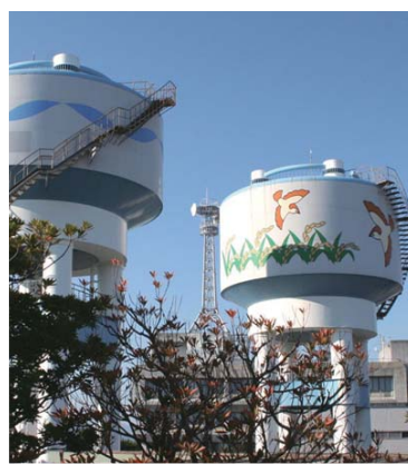
弥富揚水機場
