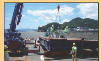
仮設橋組立訓練 (七里御浜海岸)
