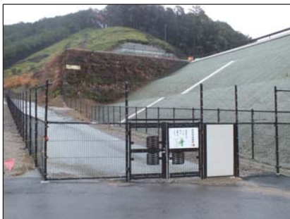
⑥. 紀伊長島区三浦 (新道瀬トンネル尾鷲側坑口)
