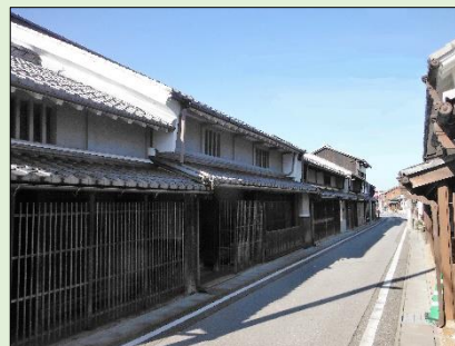
河原町芹町地区伝統的建造物群 保存地区の保存整備
