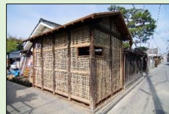
修理中の様子 (辻番所)
