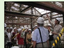
修理工事の公開 (旧池田屋敷長屋門)
