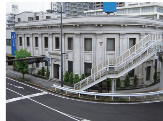
旧明和銀行本店(現中央労働金庫小田原支店) 小田原市本町二丁目1番23 この建物は、明和銀行本店として昭和3(1928)年に建てられたもの。昭和16(1941)年、六行合同により横浜興信銀行小田原支店(2代目)となり、昭和49(1974)年に移転するまで当行小田原支店であった。現在も中央労働金庫小田原支店として現役である。
