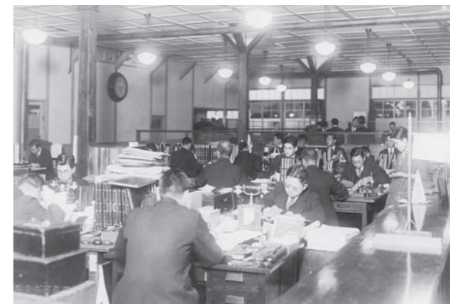
仮設の本店(営業場) 昭和4(1929)年 弁天通二丁目35番地
