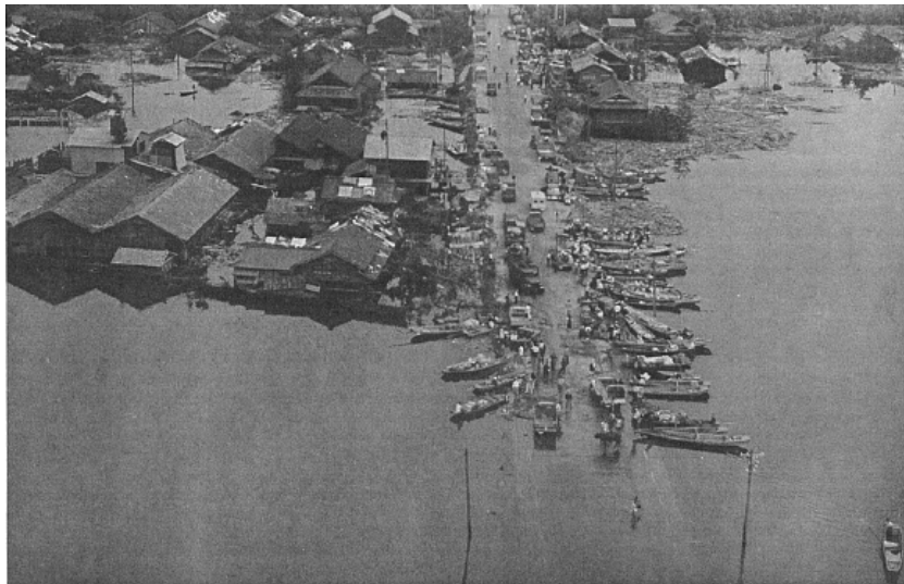
写真2-8 水没した国道1号線（海部郡蟹江町）（中日新聞社、1959）
