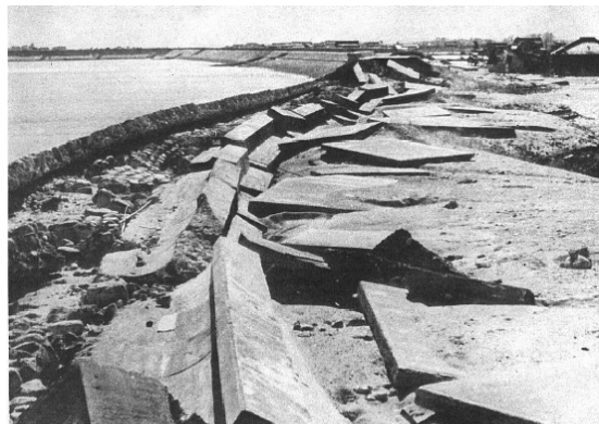
(b) 川越村地先の海岸堤防の被災
