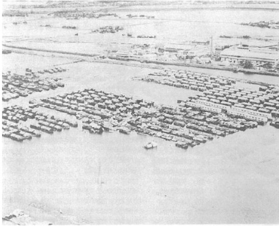
(a) 水没した低平地の都市住宅と盛土上の工場
