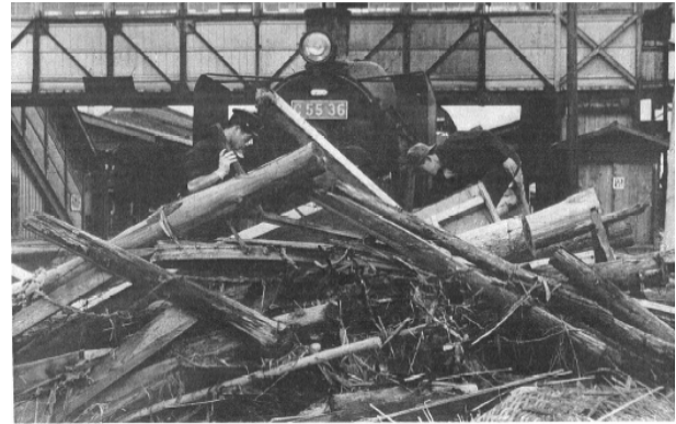
(b) 流木に埋もれた機関車（関西線富田駅）
