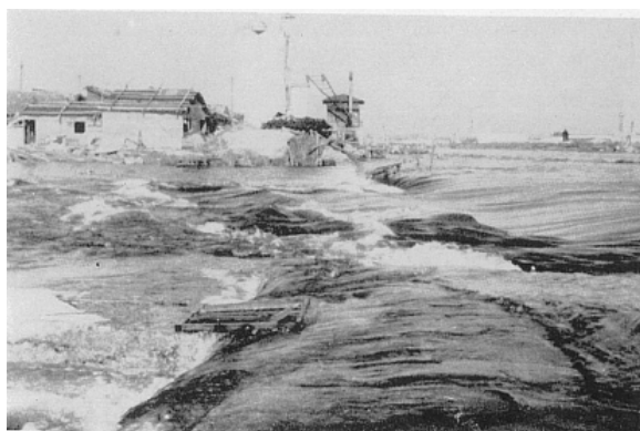
(e) 名古屋市南区を流れる山崎川右岸堤防の決壊
