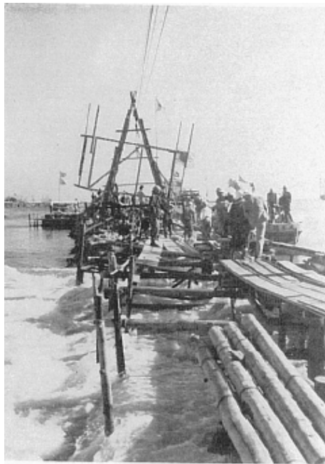
(c) 最後の締切工事 (11月20日、海部郡東末広海岸) (愛知県、1964)
