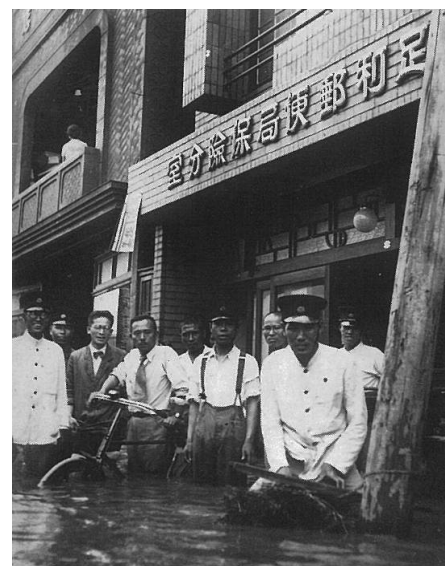
写真2-16 郵便局保健分室前（足利市）（渡良瀬川河川事務所、「カスリーン災害記録集」）
