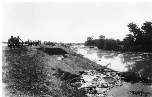
写真2-18 川辺村の浸水状況
