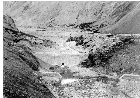
写真2-5 仁田元堰堤工事 (S15. 6. 27撮影)
