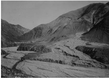
写真2-1 久蔵川の土砂流出状況（昭和13年） （国土交通省関東地方整備局渡良瀬川河川事務所）
