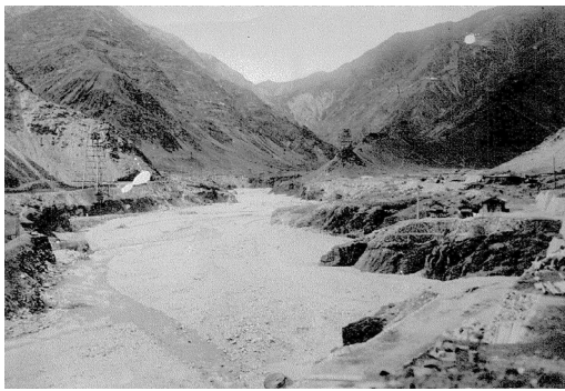
写真2-6 足尾堰堤工事着手前の河道内土砂状況 (国土交通省関東地方整備局渡良瀬川河川事務所)
