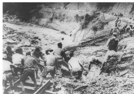
写真2-4 足尾線復旧状況 (渡良瀬川河川事務所、「カスリーン災害記録集」)
