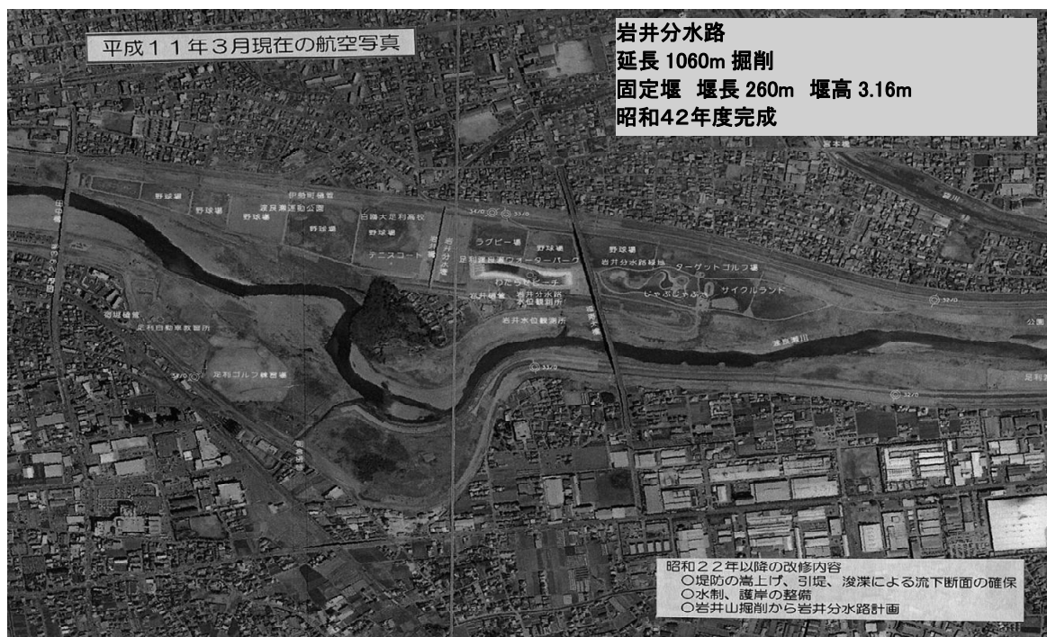
写真 2-22 現在の岩井周辺の改修と利用 (渡良瀬川河川事務所, 「カスリーン災害記録集」)
