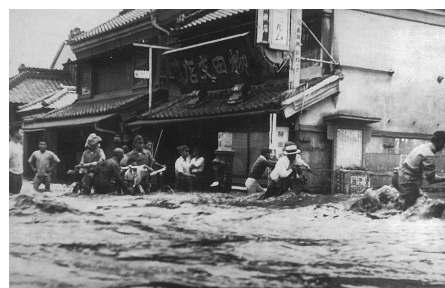
写真2-15 激しい流れの中、命綱を頼りに歩く人々（通2丁目）（渡良瀬川河川事務所、「カスリーン災害記録集」）
