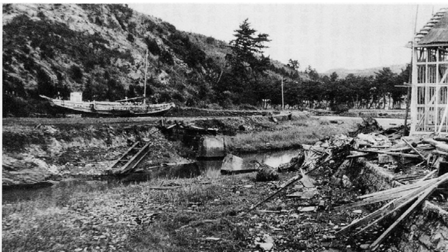
写真 2-7 江上川付近の津波被害
