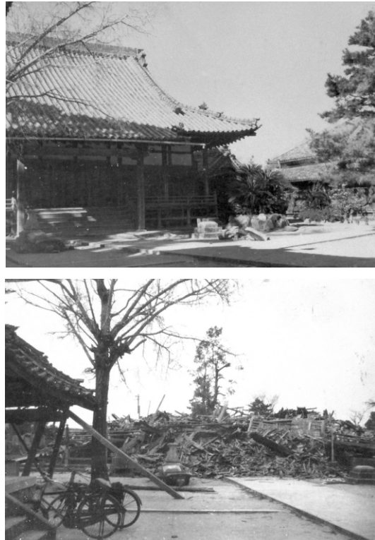
写真2 東南海地震では灯籠などが倒れる程度ですんだが（上）、その後直下に起きた三河地震では完全に倒壊した（下）（愛知県碧南市康順寺本堂のようす、同市・原田三郎さん撮影）
