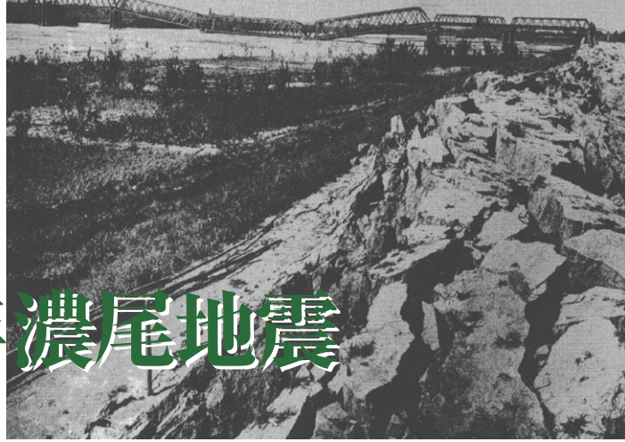
■長良川堤防の壊裂 (Milne and Burton, The Great Earthquake in Japan, 1891) 東京大学地震研究所図書所蔵
