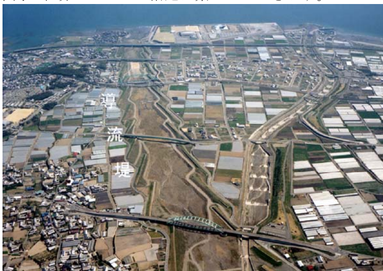
写真 6-7 安中三角地帯のかさ上げ
