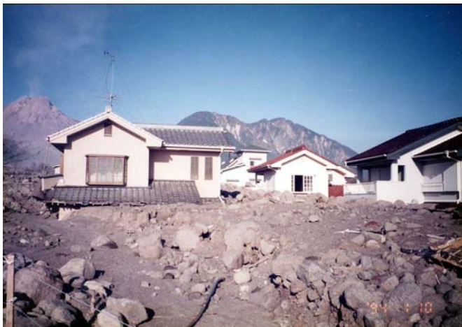
写真 6-5 土石流に埋まった家屋 撮影 伊藤和明
