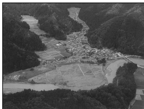
写真2 福井市蔵作町足羽川の破堤
