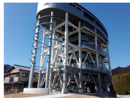
津波避難タワーの整備例(高知県黒潮町)
