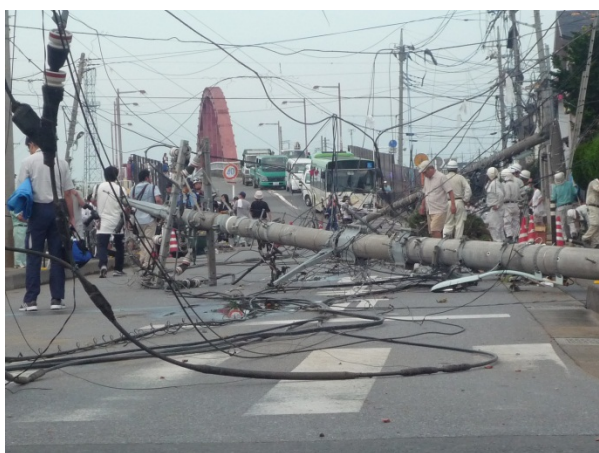
住宅街の被害状況② 【埼玉県越谷市大杉地区】
