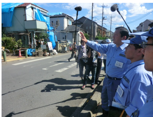
住宅街の被害状況を調査する亀岡 政務官【埼玉県越谷市大杉地区】
