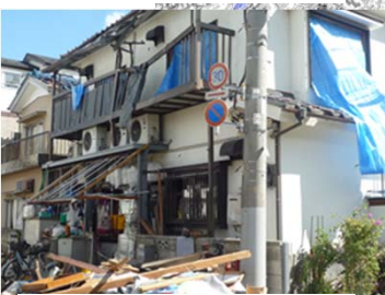
住宅街の被害の様子 (被害大)
