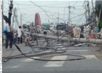
住宅街の被害の様子 (被害大)
