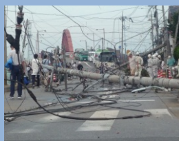
住宅街の被害の様子
