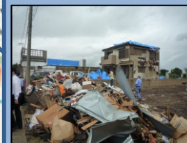
住宅被害及び撤去した 瓦礫の様子
