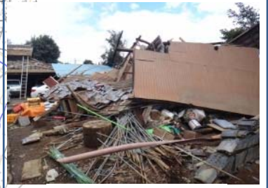
住宅被害の様子
