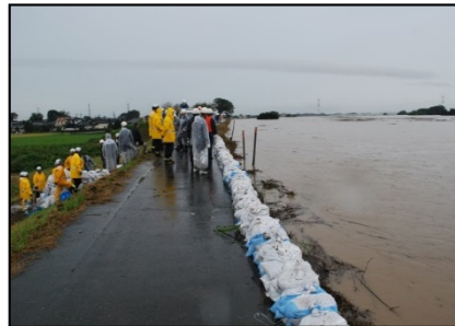
八千代町 鬼怒川右岸 (高崎地先)月の輪工、積み土のう
