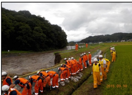
宇都宮市 田川左岸(関堀町地先) 改良積み土のう(土留鋼板使用)
