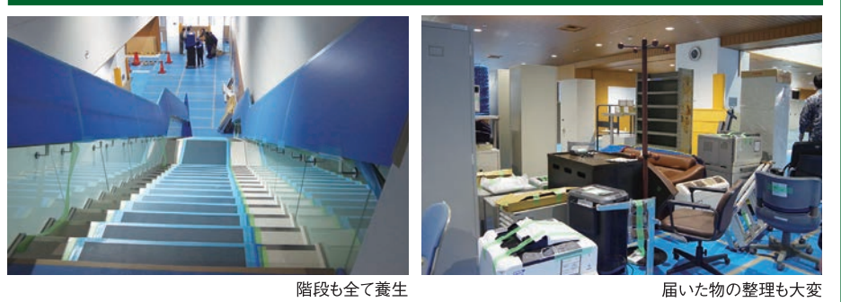
階段も全て養生
