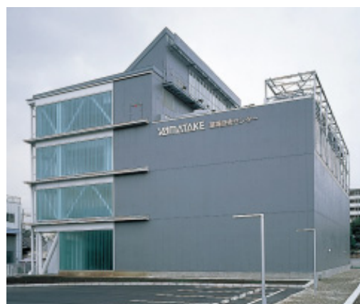
建物全体が実験設備の環境技術センター
