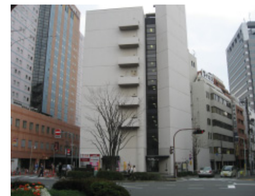
山武商会本社 (中央のビル)
