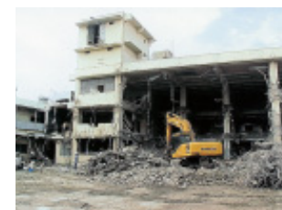
解体される蒲田工場
