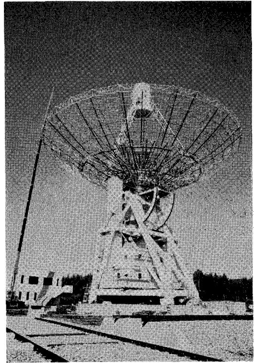
図 III-1 鏡面骨組みまででき上がった 45 m 鏡。
