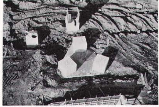
図5 干渉計ステーション基礎工事 (79/12/8)▶
