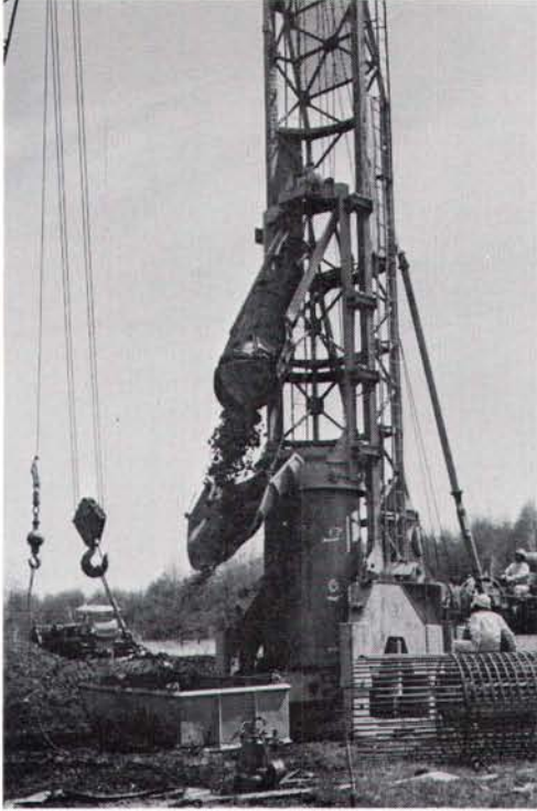
▼図3 ベント杭工事 (79/9/17)
