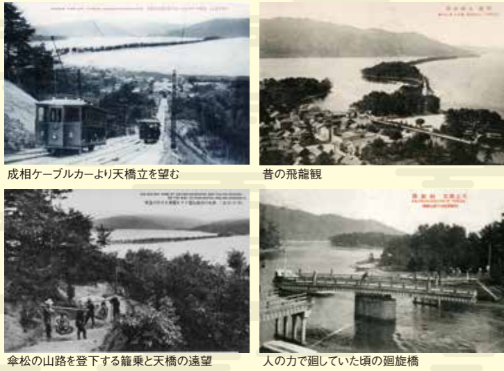
成相ケーブルカーより天橋立を望む 昔の飛龍観 傘松の山路を登下する籠車と天橋の遠望 人の力で廻していた頃の廻旋橋
