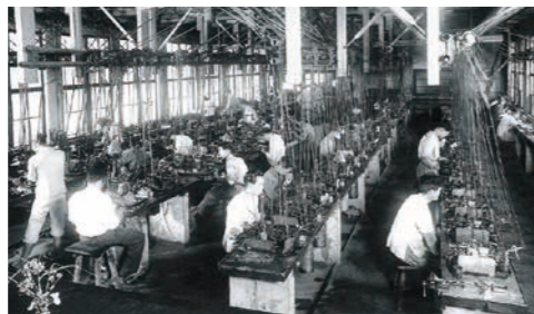
尚工舎戸塚工場 自動機 (1920年代)
