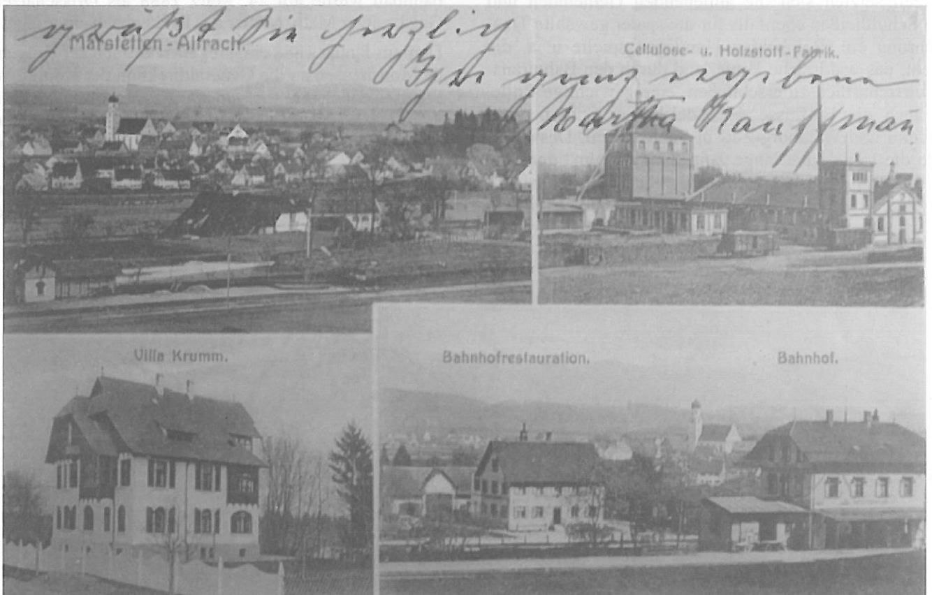
Die Postkarte von ca. 1910 zeigt unten rechts das Bahnhofsgebäude und dahinter die Restauration, beide erbaut 1888/89.
