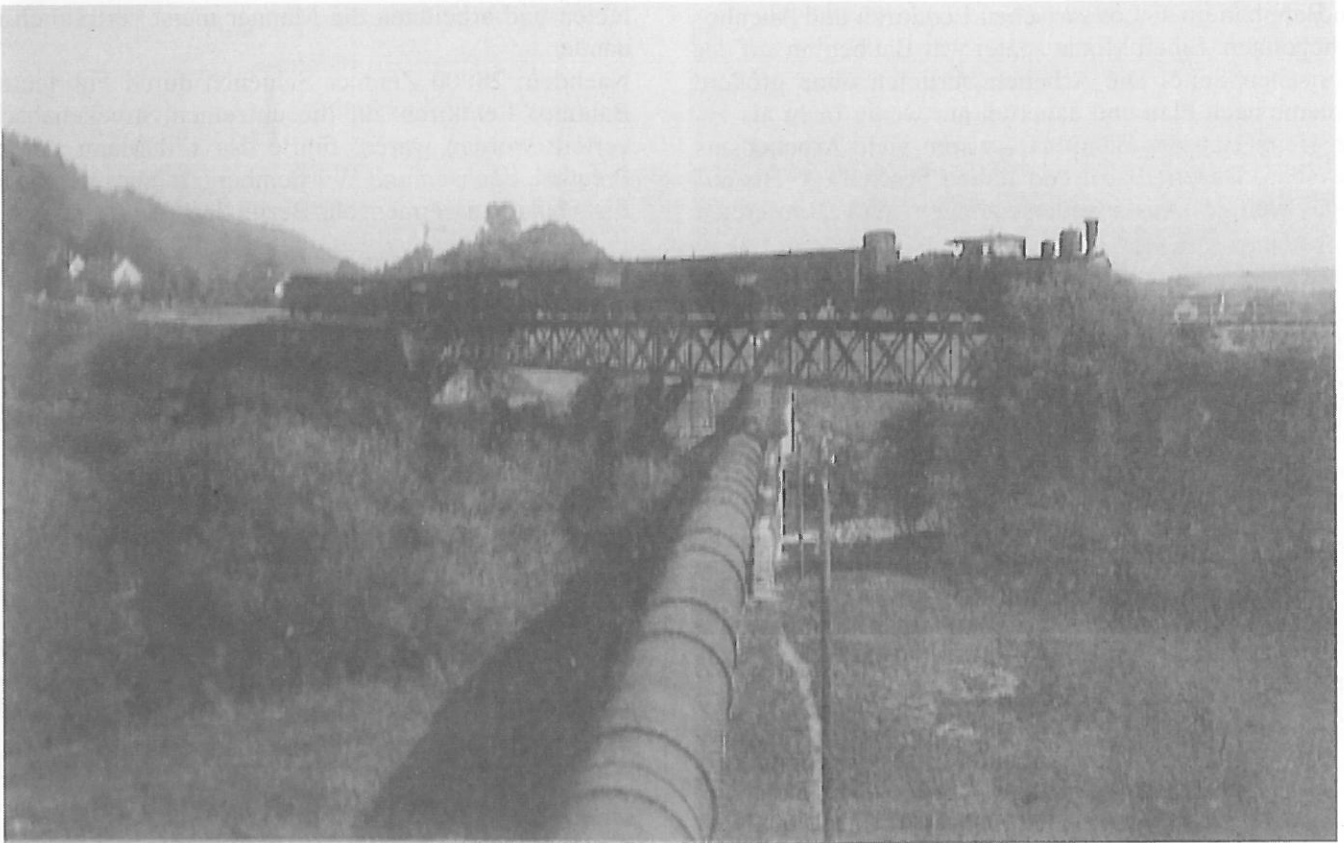
Eine württembergische Dampflok mit Anhängern überquert ca. 1911 die Aitrachbrücke bei Marstetten. Die Brücke wurde 1899 bei Probefahrten intensiv getestet.
