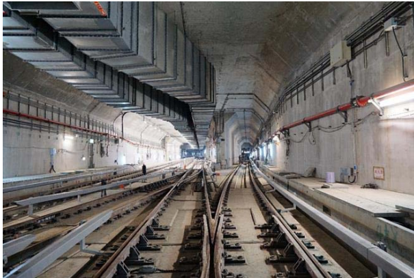
圖四 明挖覆蓋段隧道完工照片
