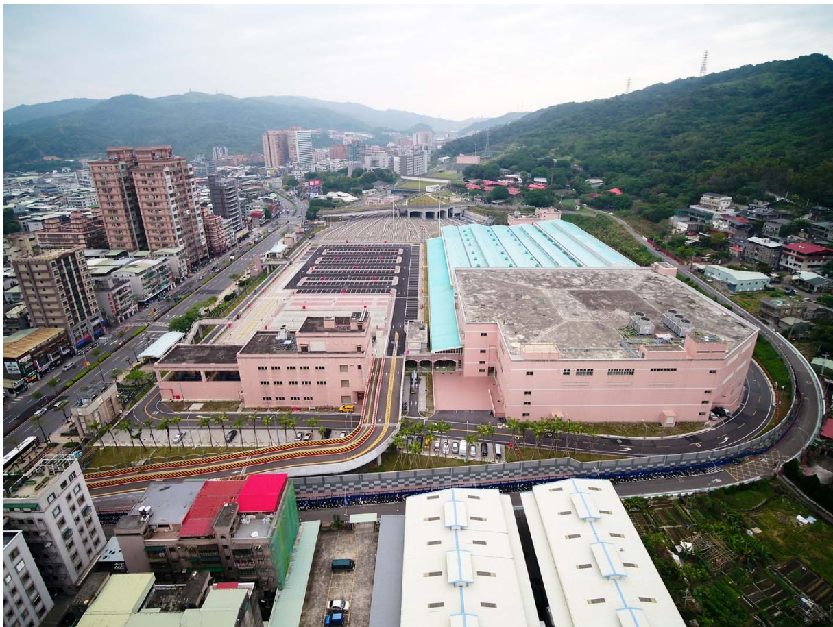
圖一 全區完工照片
