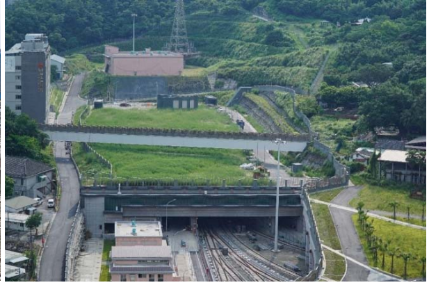
圖三 延伸段隧道完工照片
