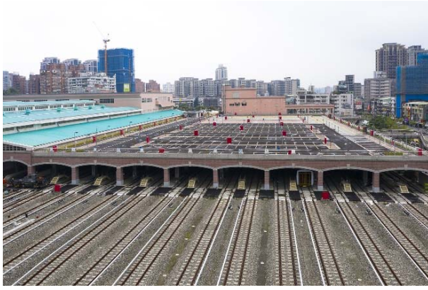
圖二 駐車廠完工照片
