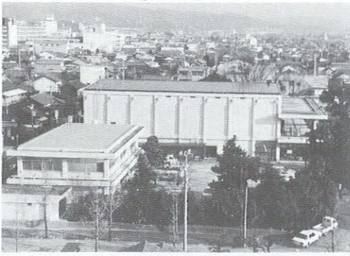
▲完成間近な「せきれいホール」
