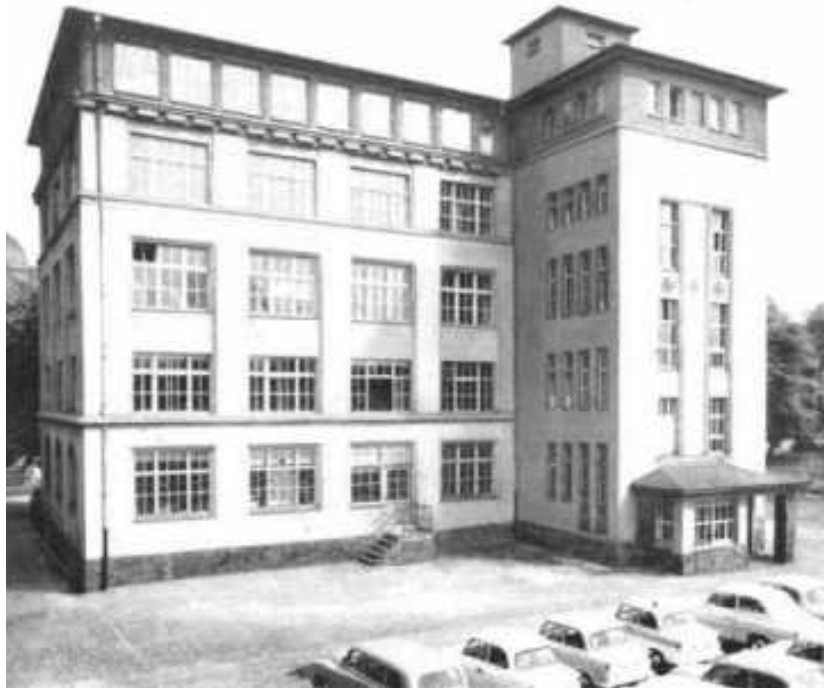
Das Institutsgebäude in der Alchemnitzer Straße
