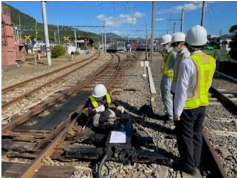
転てつ器（ポイント）操作訓練
