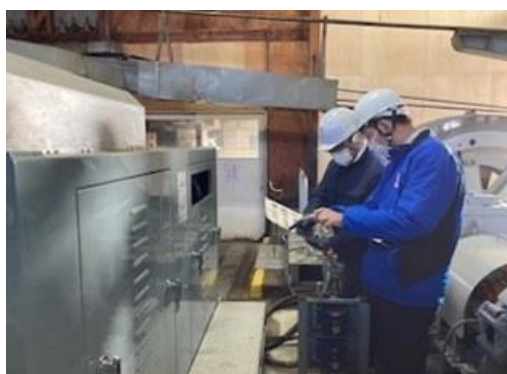
非常用発電機稼働訓練
