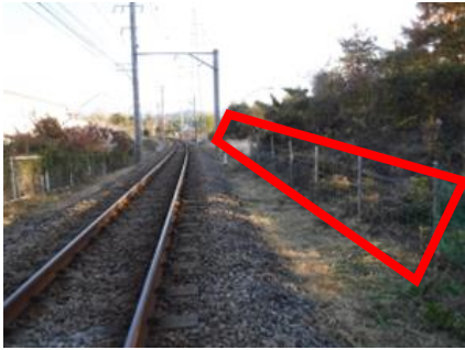
侵入防止柵の延長
