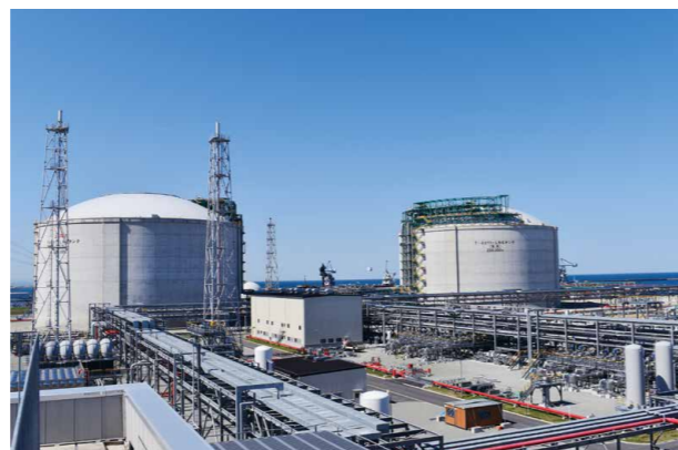
△ 相馬LNG基地
