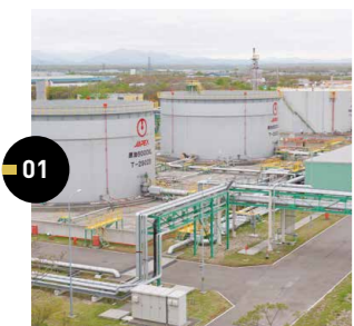
01 勇払油ガス田 油ガス田 北海道苫小牧市 発見:1989年 生産開始:1996年
