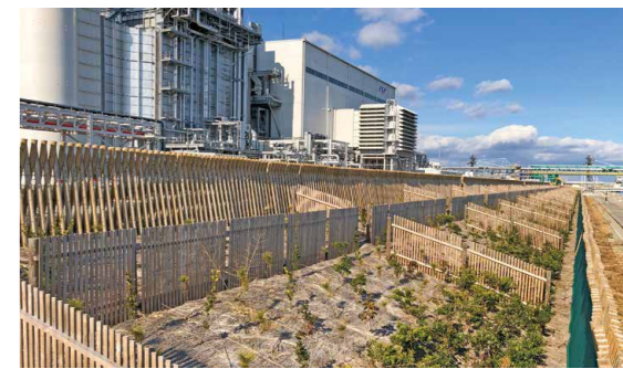
△ 福島天然ガス発電所での在来種を用いた緑化工事
