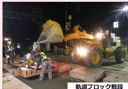
軌道ブロック敷設
