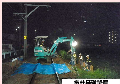
電柱基礎整備
