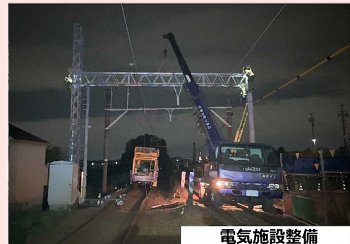
電気施設整備
