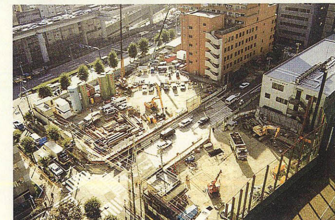
後楽側立坑(発進立坑)
