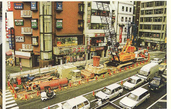
飯田橋側立坑(到達立坑)
