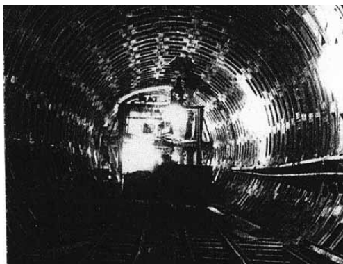
工事中の覚王山シールド(写真:名古屋市交通局提供)
