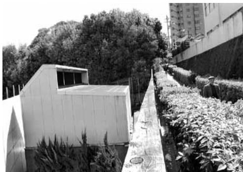
覚王山シールドトンネルの発進基地の跡。 北側が換気口として使われている
