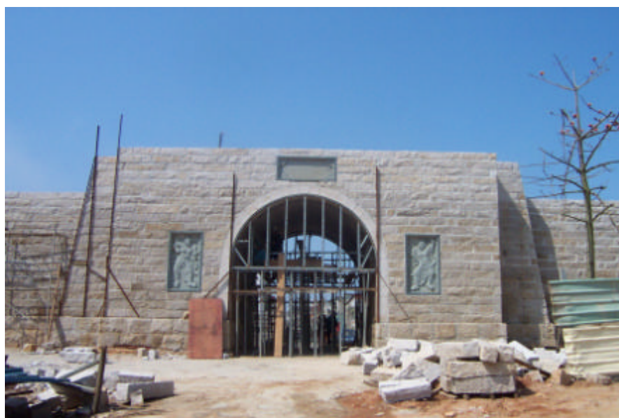
圖 3-9：金門城村北城門重建現施工現況
