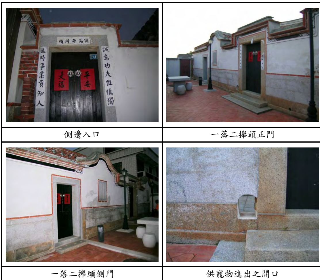
附表 4-22-2 水頭蔡開國、蔡開盛宅（前水頭 64 號）之現況照片
